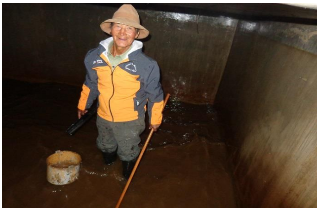
Ein Mitglied des Wasserkomitees bei der Reinigung des Wassertanks.
