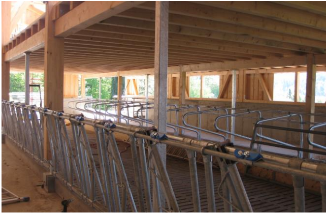
Der neue Stall ist bald einzugsbereit.
