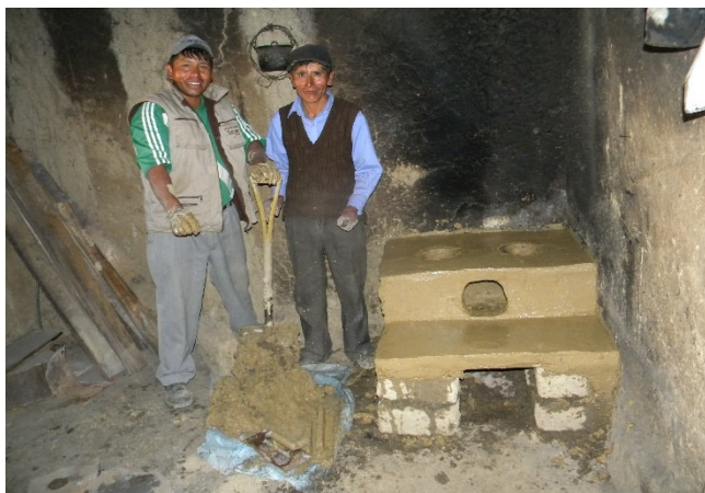
Beim Bau der separaten Küche mit verbesserter Kochstelle mit Rauchabzug.
